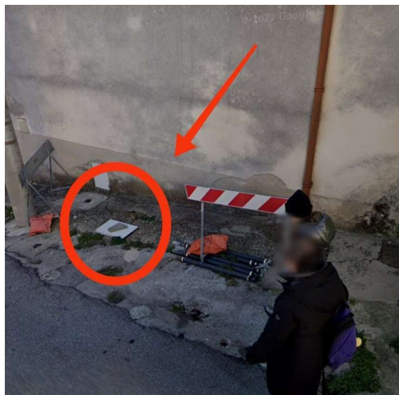
FOTO 2 PRIMA DEI LAVORI
