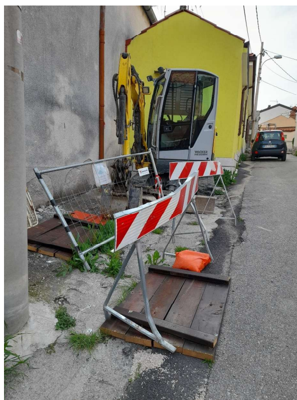
FOTO 4 DURANTE I LAVORI
